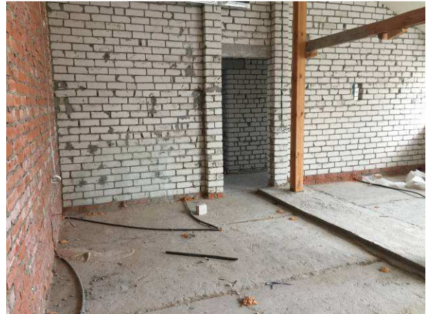
Состояние и уровень отделки внутренних помещений
