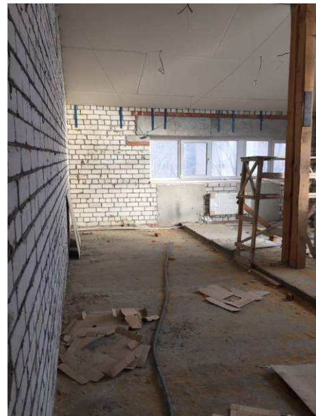
Состояние и уровень отделки внутренних помещений
