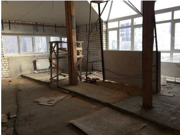
Состояние и уровень отделки внутренних помещений
