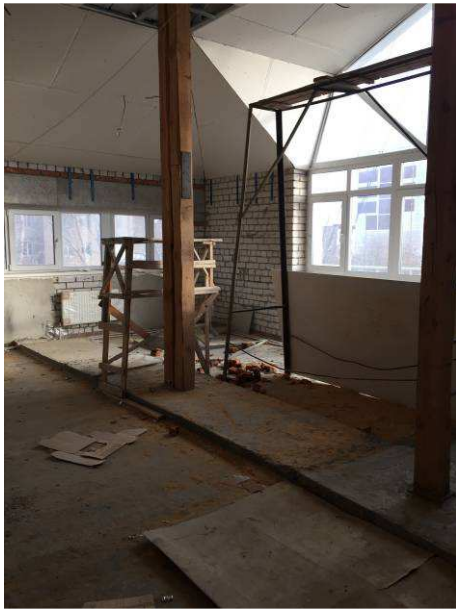
Состояние и уровень отделки внутренних помещений
